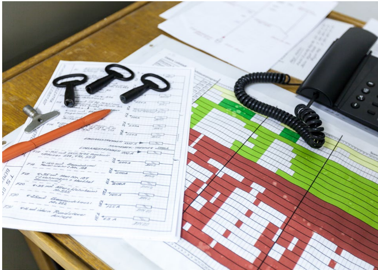
Schreibtisch in der «Trafostation 00» beim Gemeindehaus
