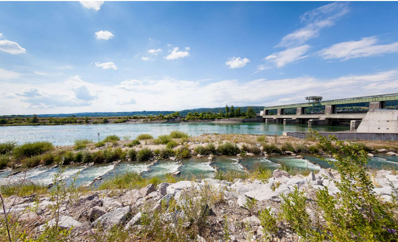
Wehrkraftwerk / Dotierkraftwerk RADAG beim Stauwehr in Leibstadt Inbetriebnahme: 4. Dezember 2009, installierte elektrische Leistung: 24 MW Die Fischtreppe im Vordergrund ermöglicht den Fischen den Aufstieg vorbei am Kraftwerk
