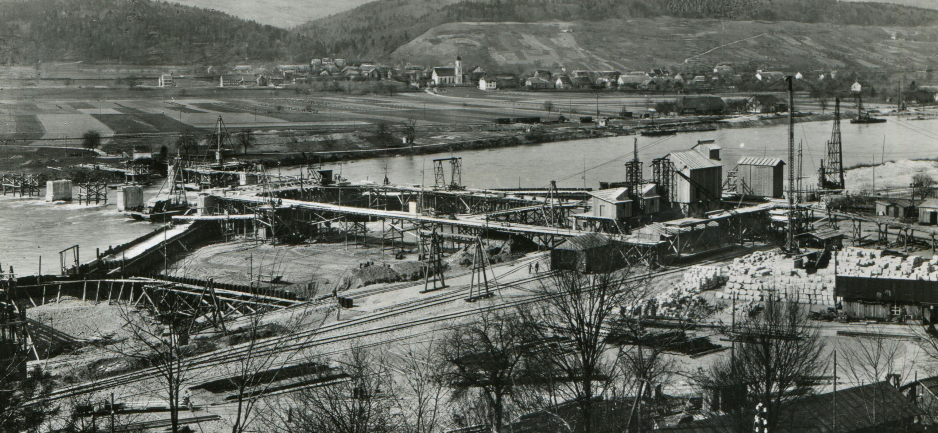
Bau Stauwehr Leibstadt-Dogern 1930
