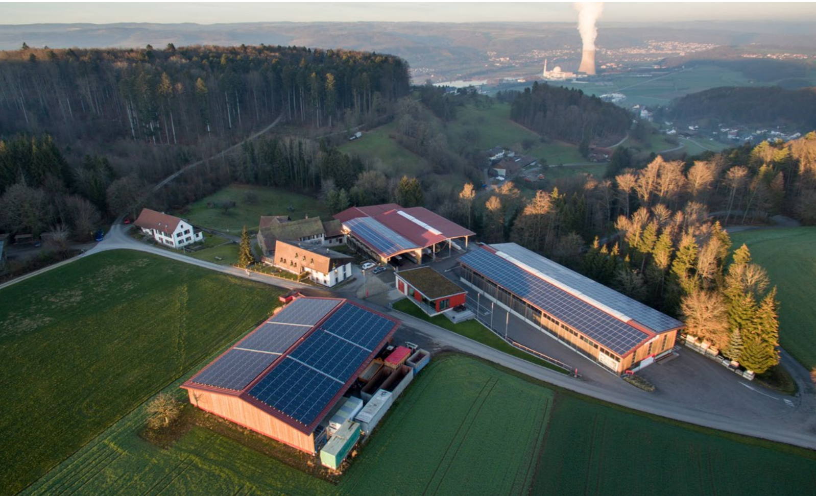
Kalt AG, Bossenhaus. Eine von sechs Photovoltaikanlagen in Leibstadt Installierte Leistung: 312 kWp
