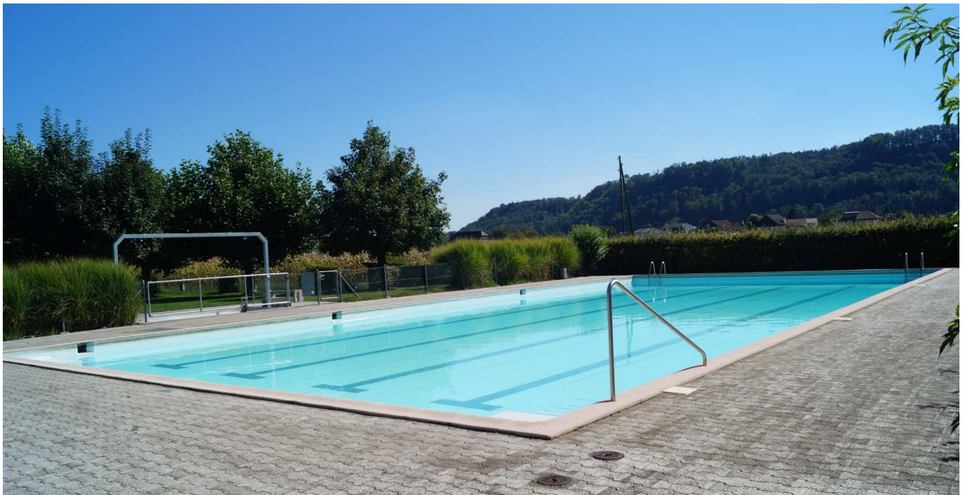
Schwimmbaden vor der Sanierung
